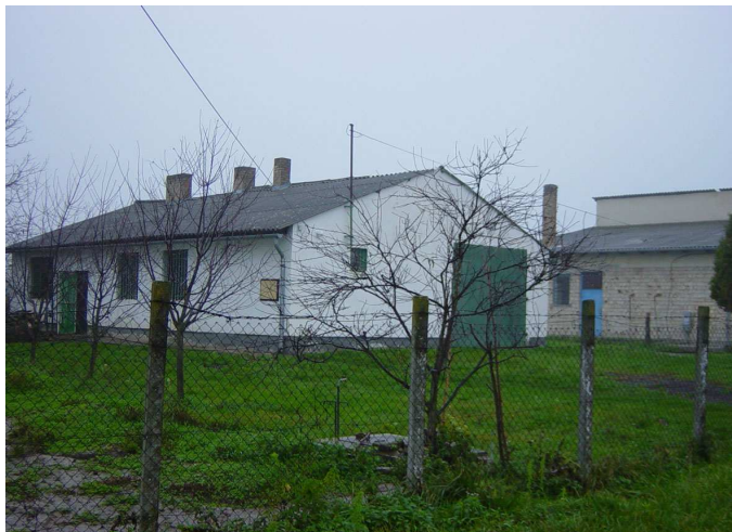
67/4 hrsz volt tűzoltószertár
